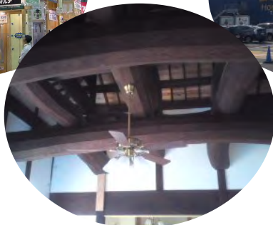
新宮再生古民家
